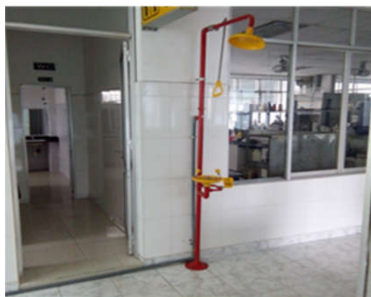
Hình 7. Vòi phun mưa rửa hoá chất dính phải tại IUH
